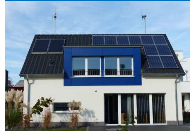
Entkoppelte Aufdachmontage unter den Ziegeln
